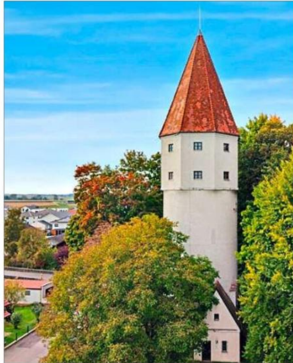
Der Historische Wasserturm Osterhofens steht zum Verkauf. Die Stadt hat keine Verwendung mehr dafür.
