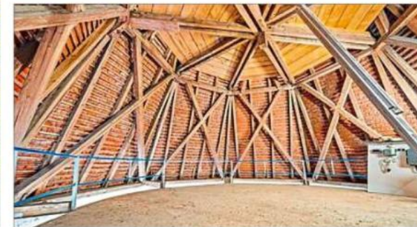
Ein Blick ins Innere: Der zukünftigen Nutzung des Wasserturms seien keine Grenzen gesetzt, sagt Makler Oliver Herbst.
