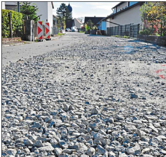
Groß, grob und spitzkantig ist der Kies, der derzeit die Dorfstraße in Arbing abdeckt – zum Ärger der Autofahrer. Er soll später wiederverwendet und zur Stabilisierung von Gräben eingesetzt werden. – Foto: Schwarzbözl
