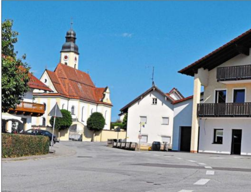
2027 wird im Zuge der Dorferneuerung in Obergessenbach die Josefstraße saniert: Sie wird aufgeweitet und erhält einen Gehweg. Die Friedhofsmauer soll zurückgesetzt werden. – Foto: gs
